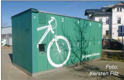
Die grünfarbigen Container enthalten jeweils abgeschlossene Boxen und diese sind mit einer Laufschiene für den sicheren Stand des Rades in der Box ausgestattet. Bei der zweigeschossigen Ausführung senkt man die Laufschiene der oberen Box auf Gehwegniveau ab.
