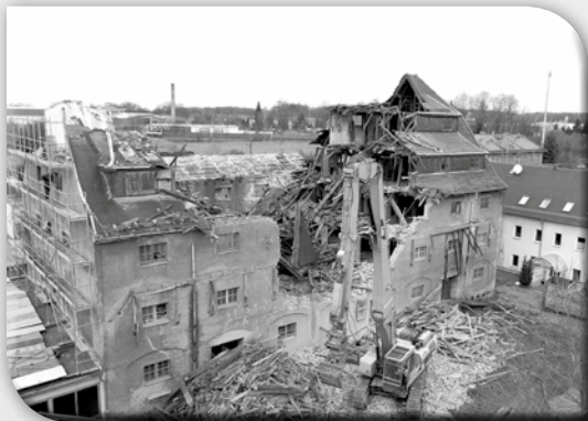
Abriss des ehem. Speichergebäudes Oberlichtenau Foto: OSL
