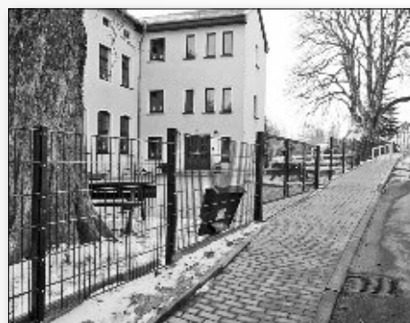
Neue Einfriedung an der Grundschule Auerswalde Fotos: Dr. Michael Pollok
