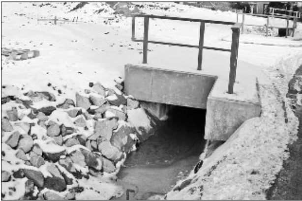
Brückenneubau im Zusammenhang mit dem Ersatzneubau des Garnsdorfer Feuerwehrgerätehauses
