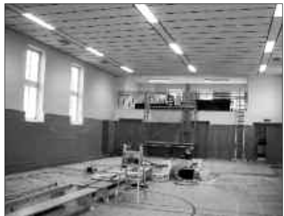
Turnhalle Ottendorf Nach Wasserschäden in Folge der Schneeschmelze erhält die Turnhalle einen neuen Anstrich
