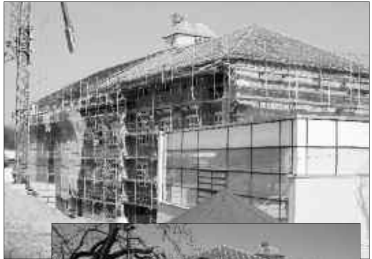
Baufortschritt neue Mittelschule Lichtenau Nach den Sparren wird nun das Dach gedeckt
