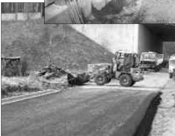
Am Dienstag, dem 12.04.2011 wurde die Asphaltdeckschicht aufgebracht. Am Freitag, dem 29.04.2011 findet die Bauabnahme statt.
