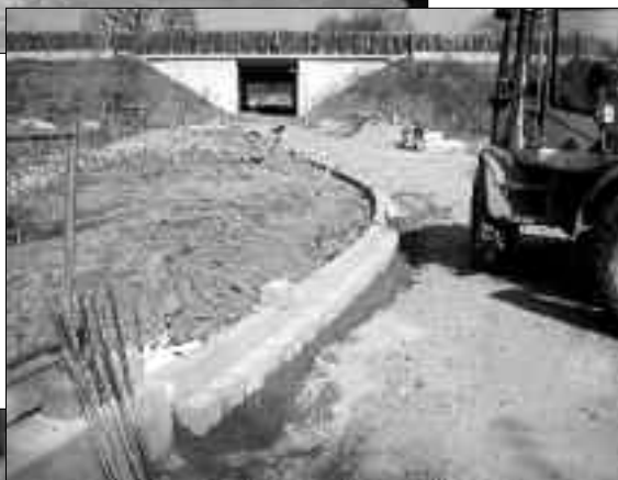
setzen der Bordsteinkanten am „Doppelhaus“
