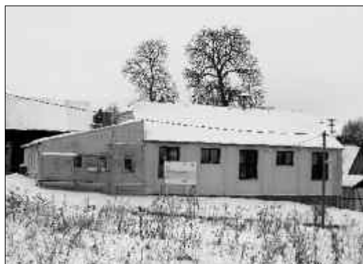
Turnhalle Niederlichtenau vor der energetischen Sanierung
