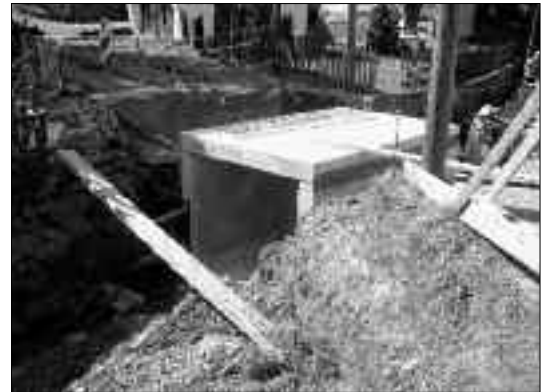
Ersatzneubau Brücke Auerswalde
