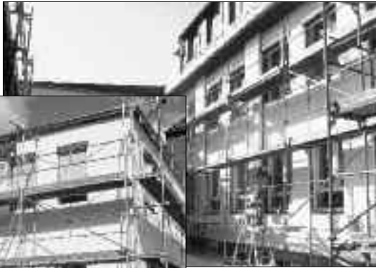
KP II-Maßnahme Vollwärmeschutz
