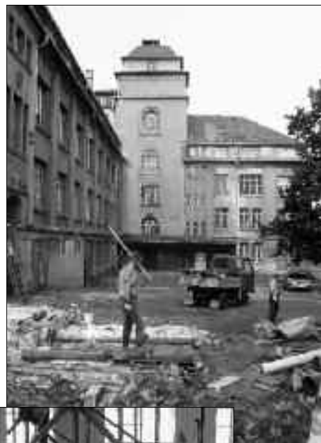
Neue Mittelschule Lichtenau Abrissarbeiten
