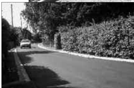
Obere Siedlung Auerswalde – Straßenbau
