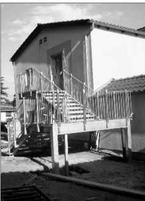
neue Rettungstreppe Hort Auerswalde
