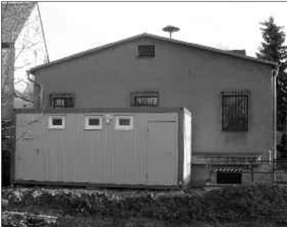
Neuer Sanitärcontainer am Feuerwehrhaus Garnsdorf – Abschluss der Arbeiten steht bevor
