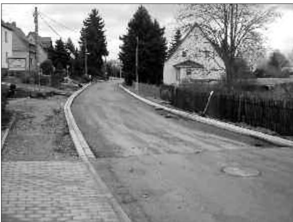
Merzdorfer Straße Bei Plusgraden konnte die Tragschicht der Merzdorfer Straße (2. BA) OT Niederlichtenau aufgebracht werden.
