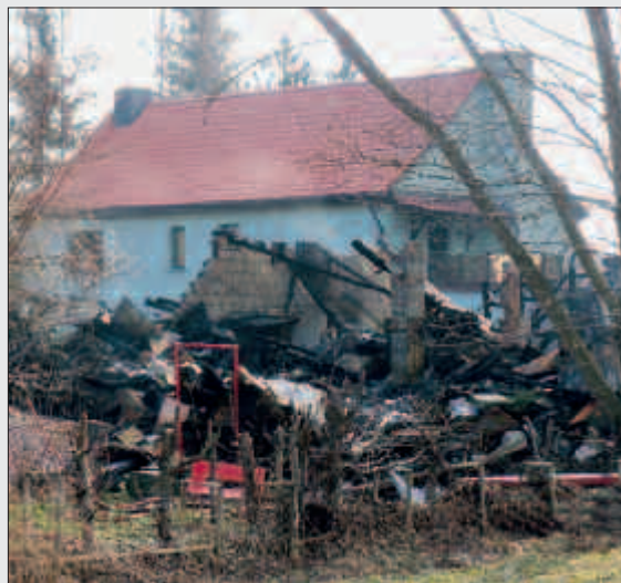
zerstörte Scheune im OT Auerswalde vom 02.03.2010
